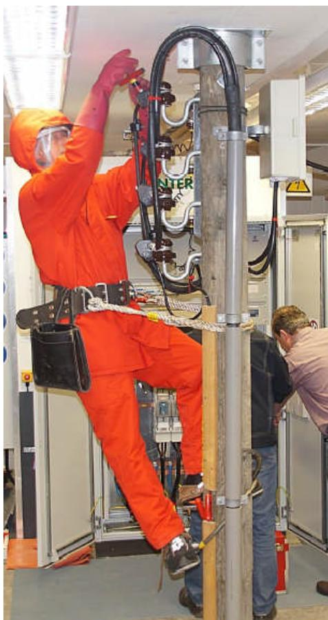
Auf diesem Mast können unter Spannung Hausabzweigungen hergestellt, zwei spannungsführende Kabel parallel geschaltet und der Austausch von Überspannungsableitern trainiert werden. Auch im Kabelnetz des KFE-Trainingscenters können seit neuestem zwei unter Spannung stehende Kabel parallel geschaltet werden.
