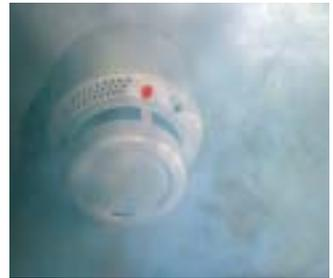
Zur Selbstrettung bleibt nach Ausbruch eines Brandes nur die kurze Zeitspanne von zwei bis vier Minuten! Je früher der Brand bemerkt wird, desto größer die Chance der Rettung. Rauchmelder alarmieren rechtzeitig und ermöglichen die Flucht.
